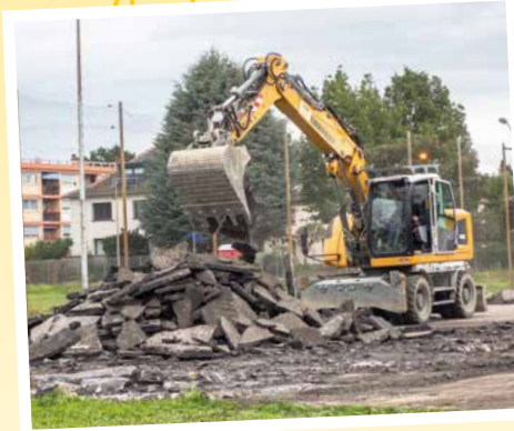
10 septembre - Démarrage du chantier du Pôle intergénérationnel
