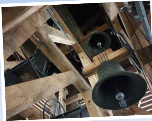
Mars - Étude vibratoire avant sécurisation du beffroi de l'église catholique
